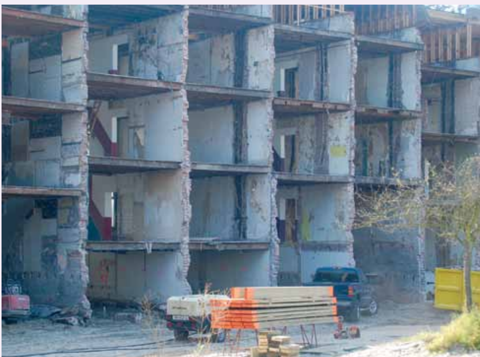
ACHTERGEVEL KLUSHUIZEN IN ROTTERDAM VOOR EN NA DE RENOVATIE (BOVEN).
