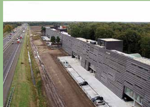
TILBURG-ZUID. GELUIDSWERENDE VOORZIENING VAN ZEVENHONDERD METER LANG EN VEERTIEN METER HOOG. EEN GELUIDSSCHERM VAN IN TOTAAL 170 WONINGEN VAN VERSCHILLENDE OMVANG EN OPZET, MET DE ACHTERKANTEN GEKEERD NAAR EEN DRUKKE SNELWEG.
