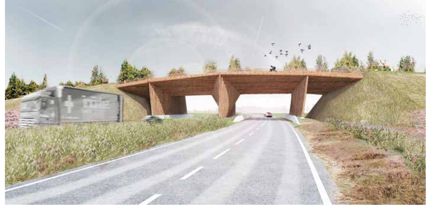
VIADUCT MET CONSTRUCTIE VAN INLANDS HOUT. ONTWERP STUDIO MARCO VERMEULEN.
