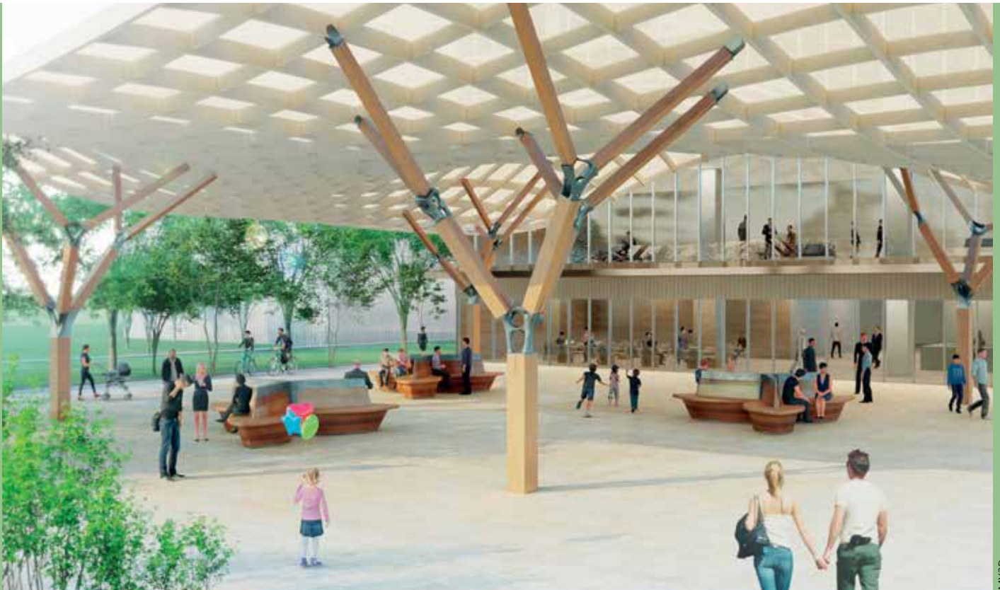
IN SAMENWERKING MET DE JAPANESE BOUWMULTINATIONAL TAKENAKA ONTWIERP EN PRINTTE MX3D EEN STALEN KNOOPPUNT VOOR EEN HOUTSTRUCTUUR.
