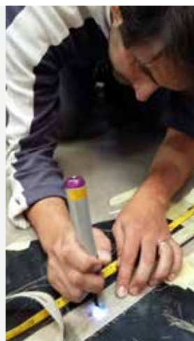
VOORBEREIDING GLASVEZEL- MEETPUNTEN
