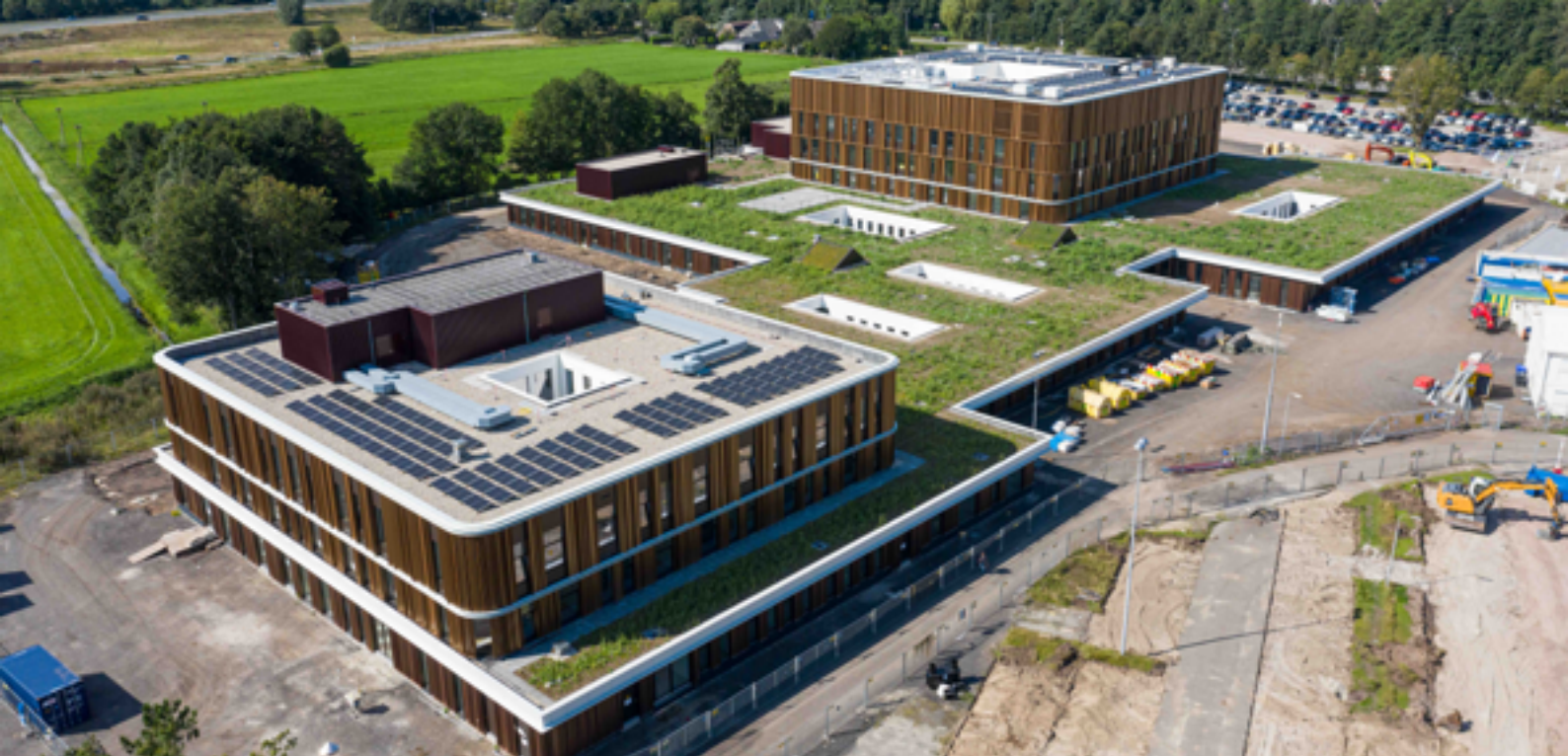
Naast het lagere sedumdak liggen er op de beide hogere daken ruim achthonderd zonnepanelen. (foto: Egbert de Boer)
